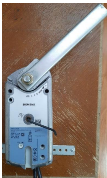
Рис 2.2. Привод Siemens GMA321.1E
